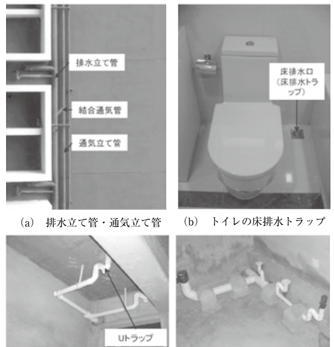
(c) 浴室床排水トラップ施工
